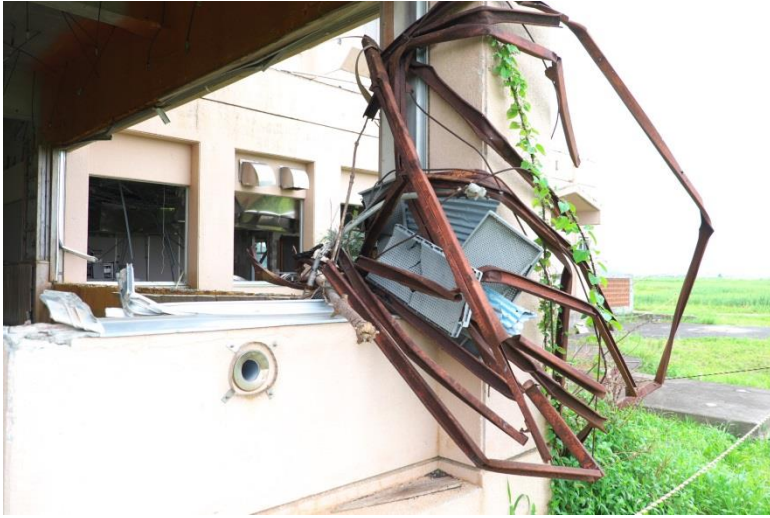
海側から津波で陸地に流され、その後引き波で学校まで流されてきた鉄骨。
